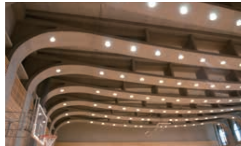
↑グラウンドの下にある体育館。最新技術でグラウンドからの振動を最小限に抑えている
