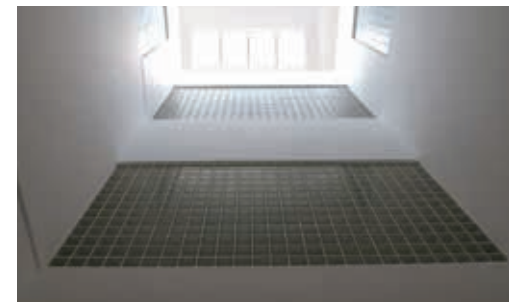
↑屋上から光と風を取り入れる高層棟の吹き抜け
