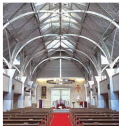
大聖堂内部半円形の鉄骨のリブとトップライトでドラマチックな空間を演出する
