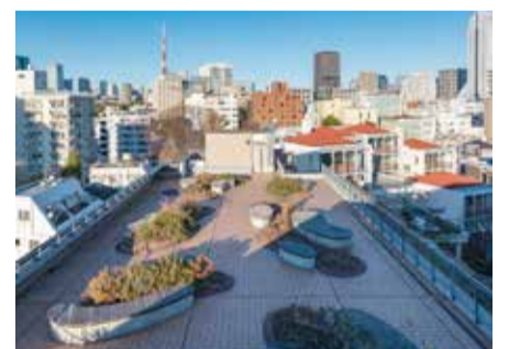
屋上緑化の様子
