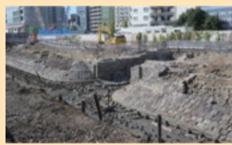
橋梁部の様子(※)
