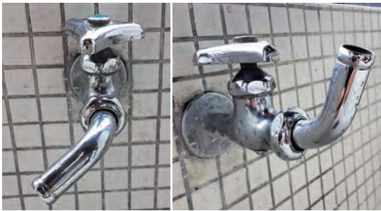
兵隊に出る前に実用新案をとっていた給水栓の出口が回転する蛇口。現在も高輪台小学校で使用されている
