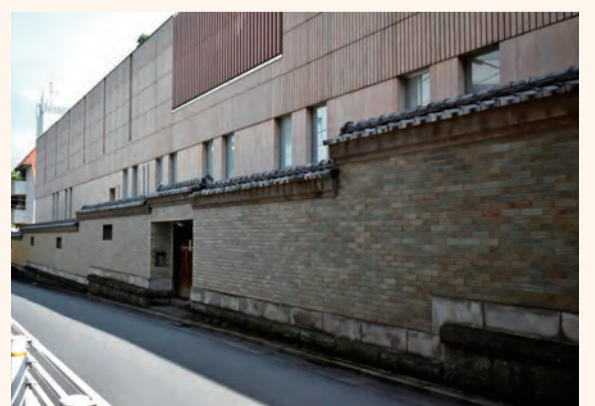
昭和初期、鈴木邸建設時に作られた塀
