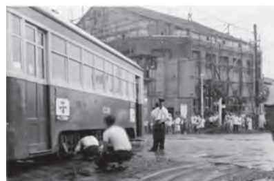
夕立の雨で土砂が流れ込み、脱線した都電魚籃坂下:昭和36~37(1961~1962)年頃 提供:高輪今昔物語デジタルアーカイブ 撮影:高野陽之助さん
