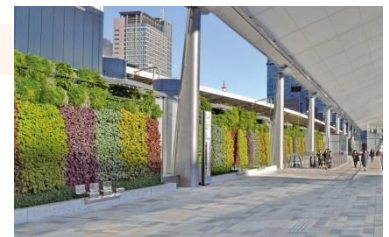
壁面緑化 (東京駅八重洲グランルーフ)
