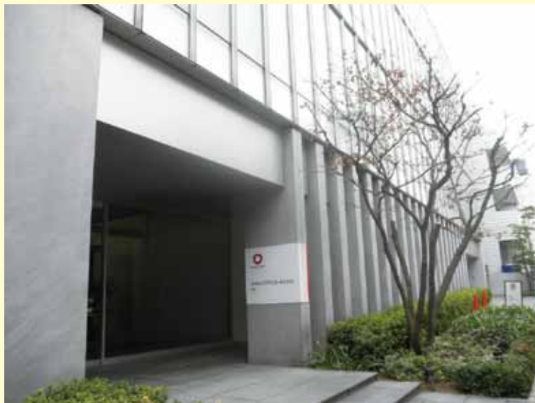
大和ライフネクスト株式会社本社ビル
