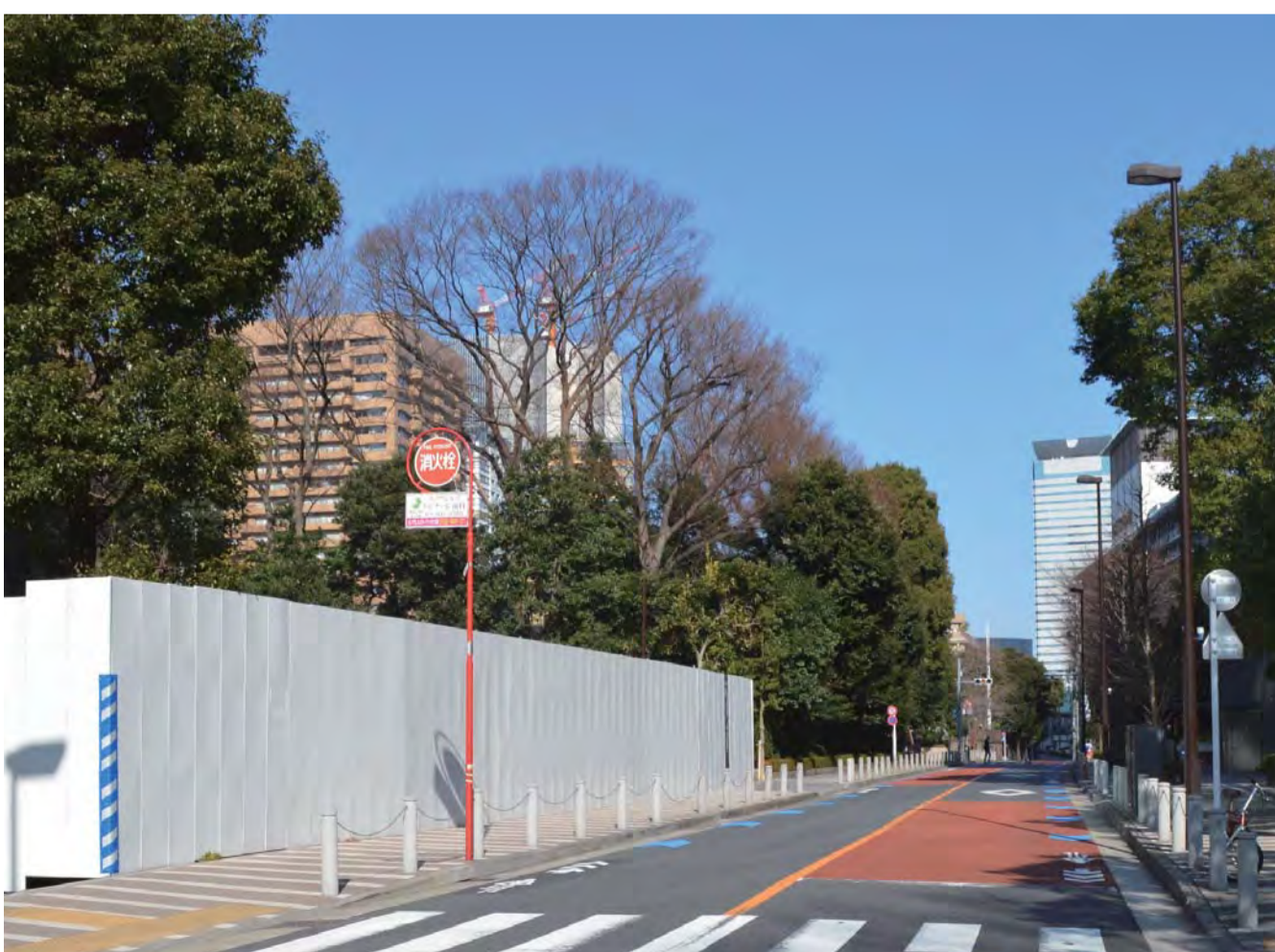
平成29年(2017年):尾根道と緑地の木々(写真中央) 東京倶楽部の手前から霊南坂方面に向かって撮影
