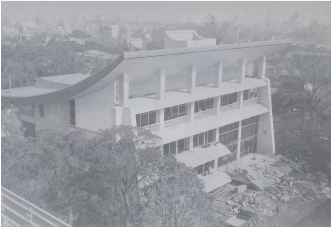
再開発に伴い取り壊される旧住友会館
