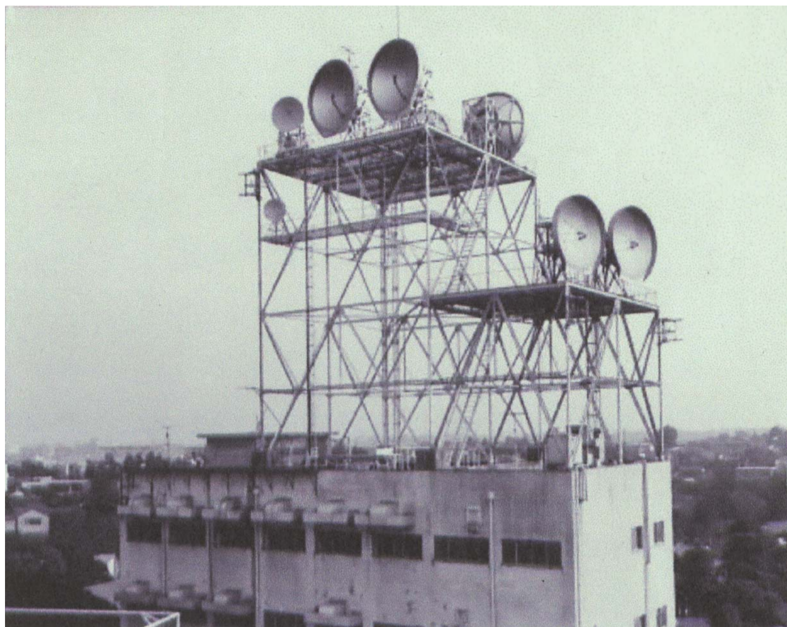
昭和30~40年代頃:東京統制無線中継所
