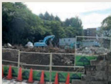
平成22年：建物が解体され、更地になっているフランス大使館旧庁舎跡。
