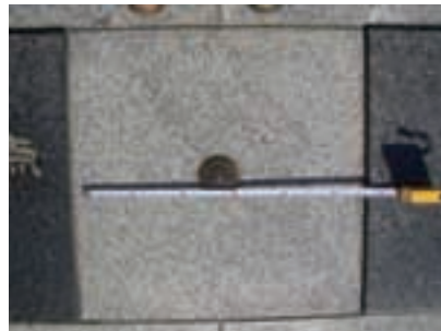
平成 24 年 (2012 年) : 金属標が大地震により約 27cm 真東に移動
