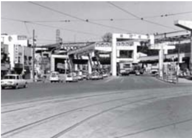
昭和42年(1967年):一の橋交差点付近から、新一の橋方面を望む。 建設中の首都高速道路「一ノ橋ジャンクション」。 【写真撮影:田口政典氏、写真提供:田口重久氏】
