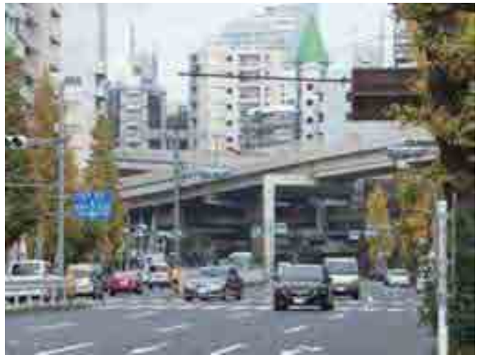
平成24年(2012年):新一の橋交差点付近
