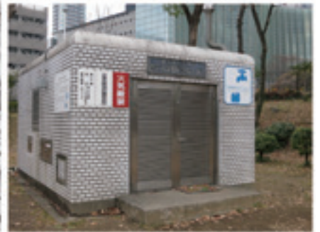
令和2年(2020年):南地区の北端には、災害時に給水ステーションとなる施設が建っている。
