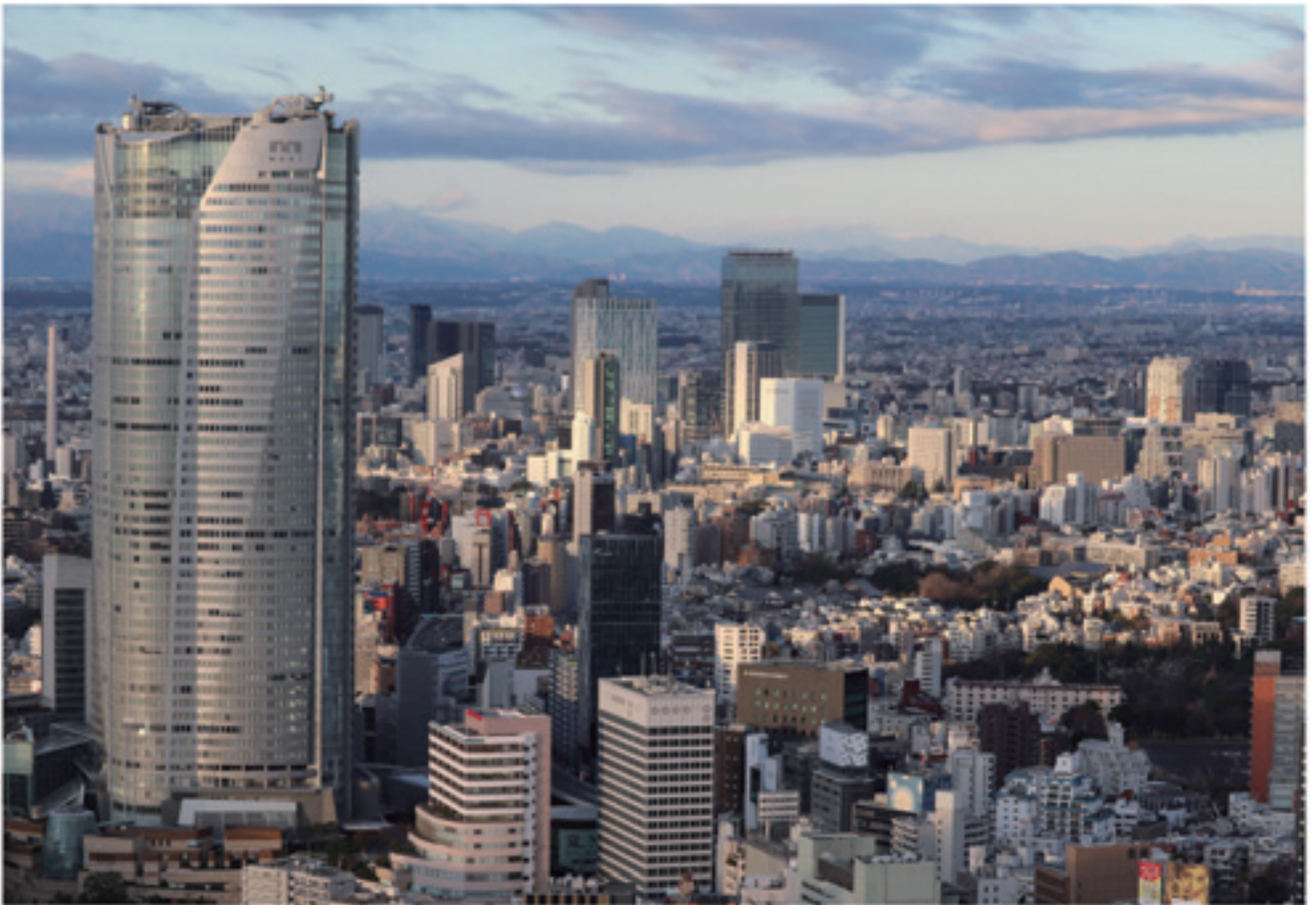
空を飛び鳥の目で見た元旦の朝の街。左手にはすっくと聳える六本木ヒルズ森タワー(高さ200m)、中央には渋谷スクランブルスクエア(約210m)をはじめとする渋谷駅周辺の超高層ビル群が見える。
