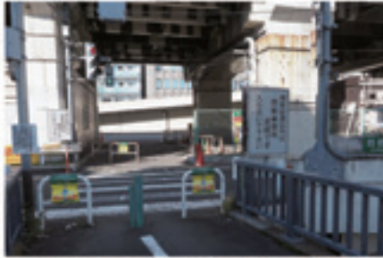
首都高速の天現寺橋出口には、珍しい信号機がある養老橋横断歩道があります。
