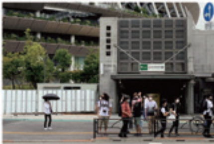
令和3年(2021年)6月:国立競技場駅と国立競技場 国立競技場方面改札(A2出口)にはエスカレーターが設置されている。
