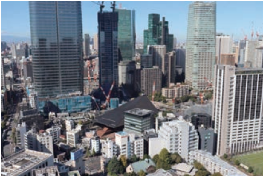
令和4年(2022年)11月2日:東京タワーメインデッキから建設中の麻布台ヒルズをのぞむ
