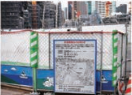
令和4年(2022年)10月:歩道橋は撤去され「歩道橋撤去のお知らせ」が掲示されています。
