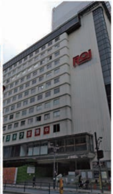
令和4年(2022年)：ロアビル わずかだが営業を続けているテナントもあり、1階のエレベーターホールへと続く入り口前の階段はパネルで覆われず、使用されている。 ビル右上の「RO」という赤いロゴは個性的で、表裏、ライトアップされて白い外壁に浮かびあがる様子はまた、独特の存在感を放つ。
