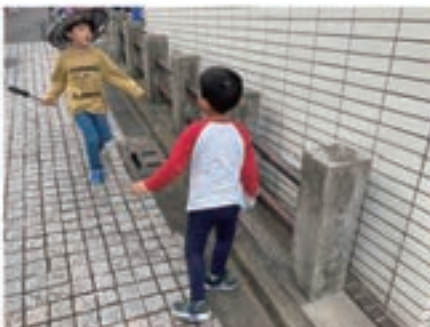
取り残された古い欄干 テレ朝通りの麻布消防署を下った宮村坂の入口に、コンクリート製の古い欄干を発見! ここは欄干があったのかな? 崖に落ちないための欄干かな? 隣接する建物との新旧のコントラストも面白いですね。
