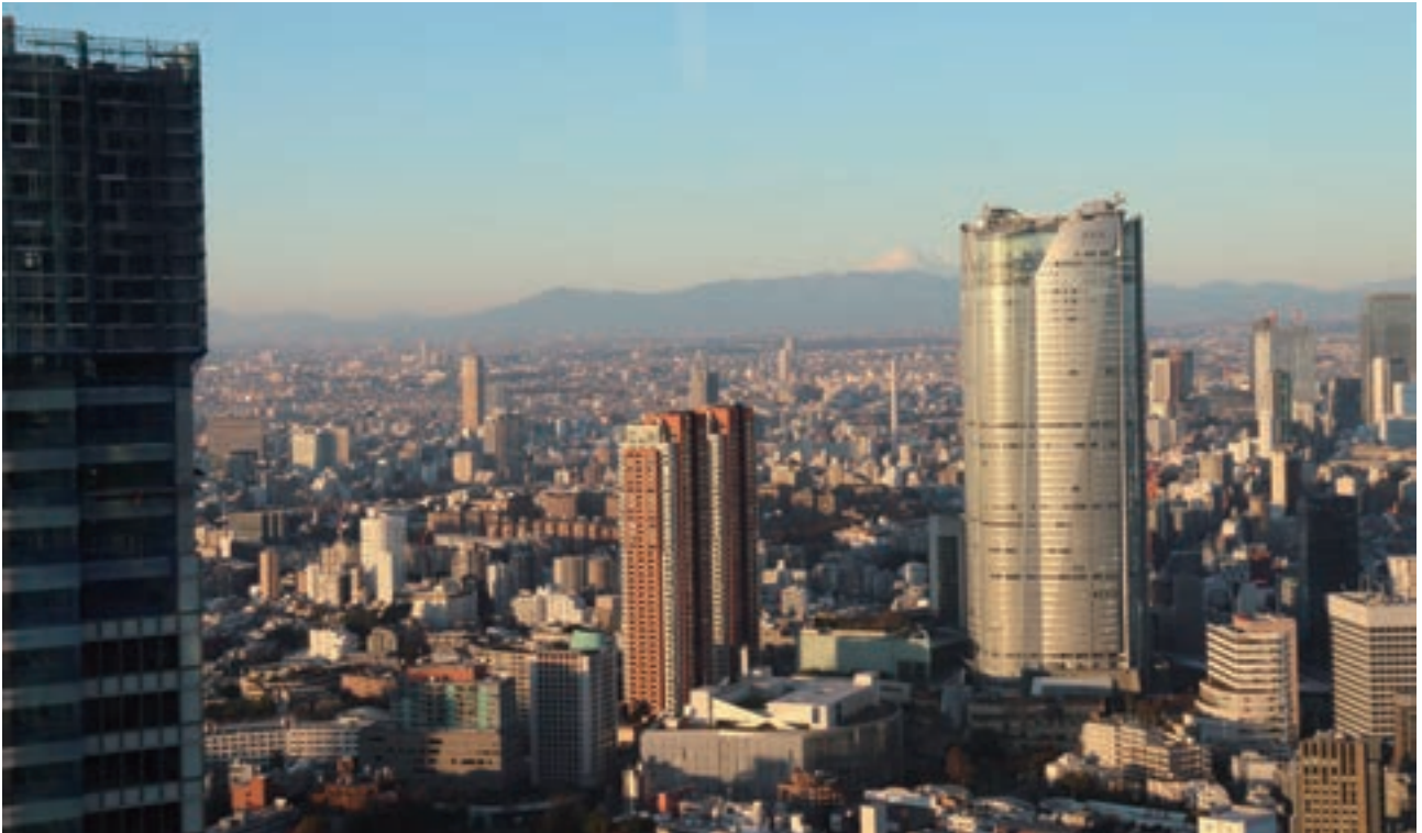
令和5年(2023年)1月1日:アークヒルズ 仙石山森タワー屋上から麻布・六本木の街を見おろす(左側に写るのは建設中の麻布台ヒルズ)
