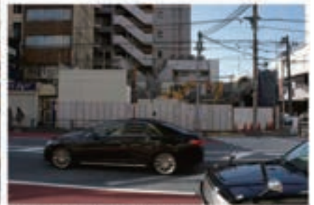
平成25年(2013年)：六本木五丁目交差点付近(上下とも) ロアビルの裏側の通りを挟んで反対側の角地、SUBWAYが入っていたビルと、米久の建物の取り壊し工事が進められている。上の写真同様、複数の電線が走る光景が日常だった。
