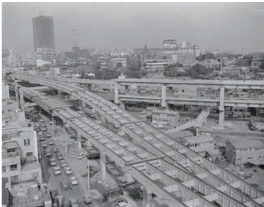
昭和 42 年(1967 年)：谷町 JCT 建設中
