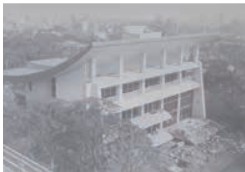
再開発に伴い取り壊される旧住友会館
