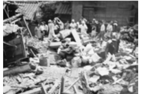
崖崩れの被害にあった民家
