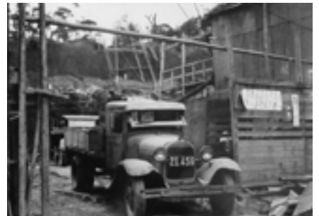
修復現場のトラック
