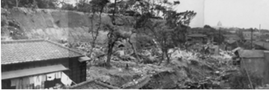
昭和 13 年(1938 年)：23 人が被害にあったがけ崩れの全貌
