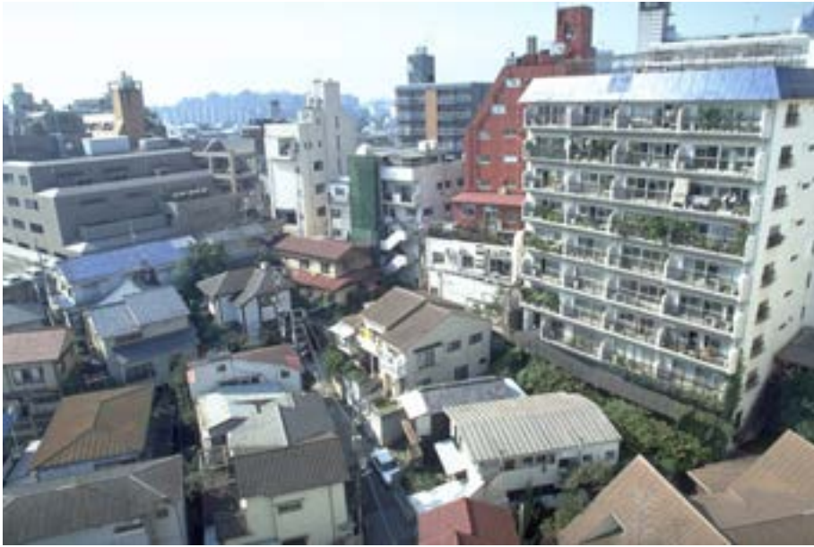
テレビ朝日・本館から玄碩坂(げんせきざか)方面を望む。右は秀和材木町レジデンス
