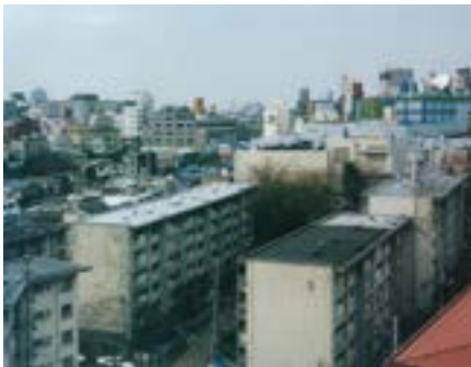
公園・北日ヶ窪住宅
