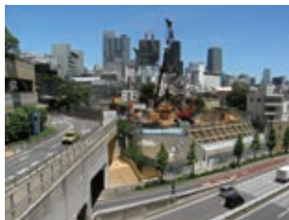
平成 27 年（2015 年）7 月： 工事中
