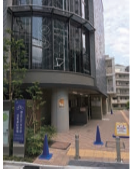
平成 30 年（2018 年）8 月： 完成した施設
