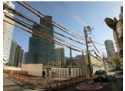
⑥ 平成 25 年 (2013 年) 11 月: 工事中
