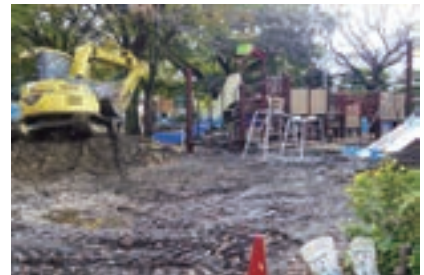
平成 24 年 (2012 年) : 遊具の再リニュー アル工事風景
