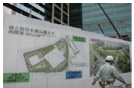
⑧ 平成 28 年 (2016 年) 4 月: 工事中
