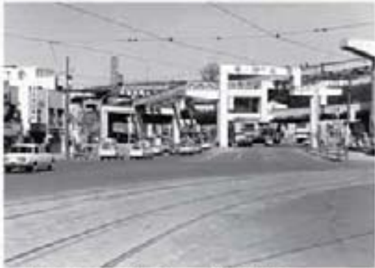
昭和 42年(1967年)：新一の橋交差点付近 一の橋交差点付近から、新一の橋方面を望む。 建設中の首都高速道路「一ノ橋ジャンクション」。
