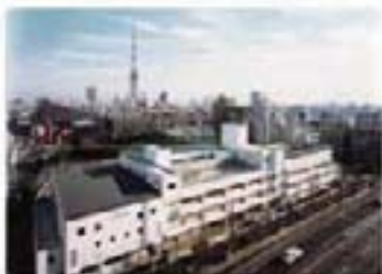
昭和58年(1983年)：麻布小学校旧校舎完成
