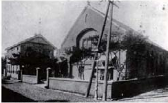
明治から大正時代：新築された麻布教会会堂 場所は、現在の東洋英和女学院東門付近。ここにもガス灯がある。
