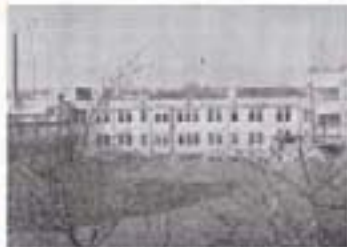
筭小学校旧校舎(光正14年(1925年)竣工)
