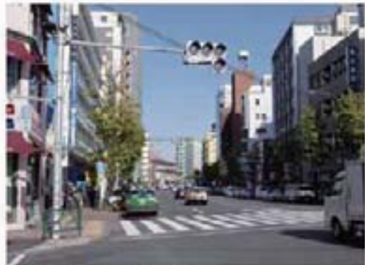
平成 24 年：広尾駅入口遠景
