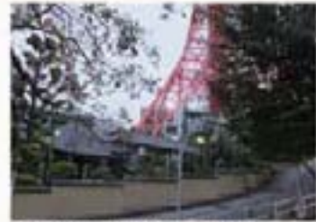
平成26年（2014年）：東京タワー西側の脚付近
