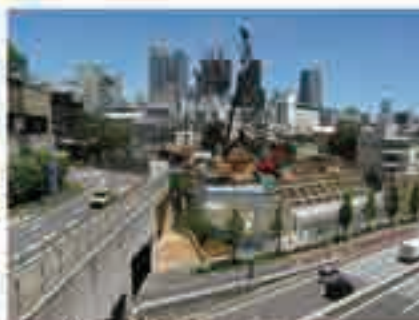
平成27年(2015年)7月:工事中
