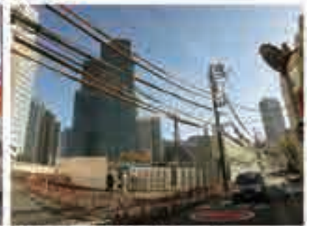
⑥ 平成25年(2013年)11月:工事中
