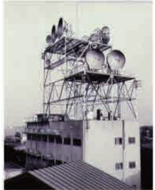
昭和30～40年代頃:東京統制無線中継所
