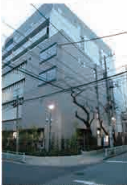
平成31年(2019年):完成して稼働した麻布警察署
