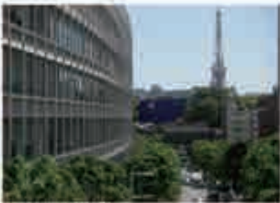
ひびき館から扇形タワー
