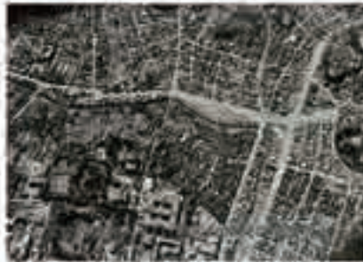
昭和32年頃(1957年頃)：ツインーの橋 建築前航空写真
