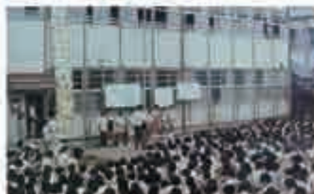
昭和51年(1976年)： 改築中に使われた仮設校舎
