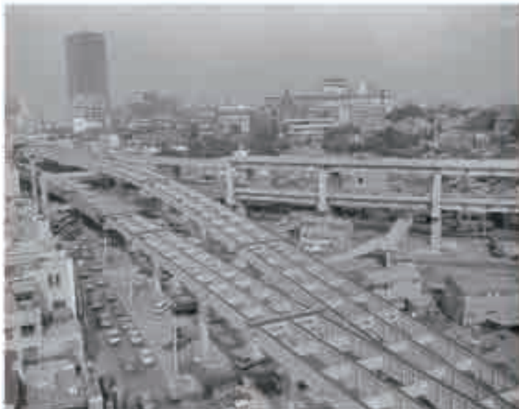
昭和42年(1967年):谷町ジャンクション建設中 建設中の路々間ビル、ホテルオークラ本館、豊南坂教会のどがった三角屋根 も見える。
