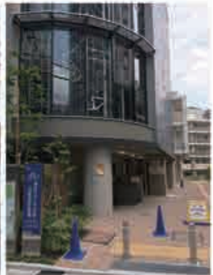
平成30年(2018年)8月:完成した施設
