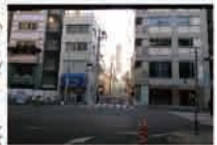
⑦ 平成25年(2013年)12月:工事中
