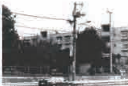
昭和63年(1988年): 筭公園と京橋に隣接するNTTのビル
