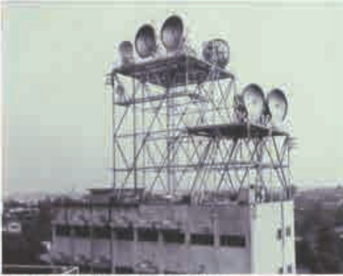
昭和30～40年代頃:東京統制無線中継所
