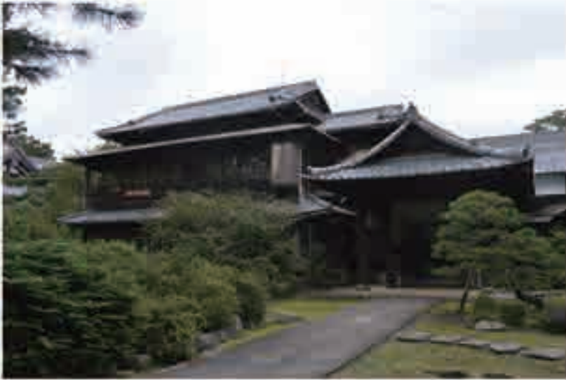
平成28年(2016年):旧鍋島邸・妙壽寺客殿全景 手前の平屋建て部分は移築の際に足されたもの
