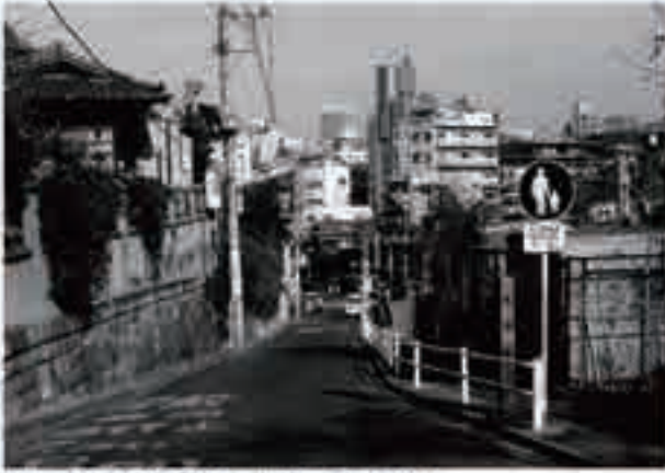
昭和 49年(1974年)：堀田坂 坂上から
