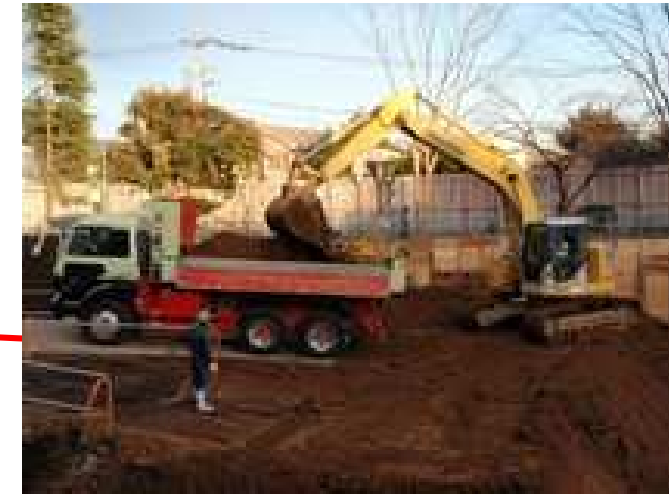
掘削作業イメージ
