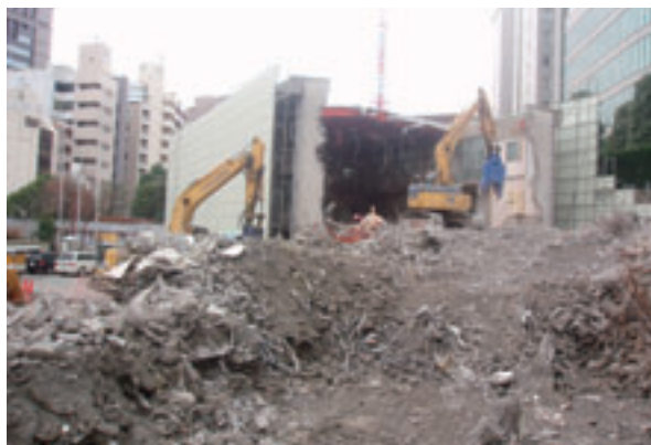
■ 解体工事の様子
