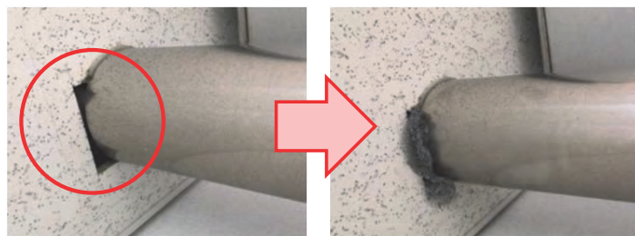
外壁の貫通口 (エアコン、キッチンの給排水・ガスの配管、配電盤など)
