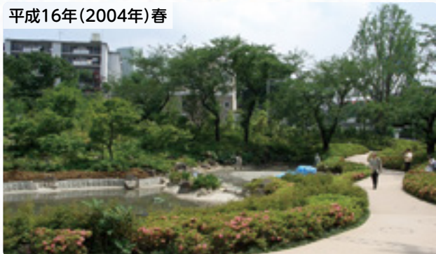
工事中の毛利庭園
