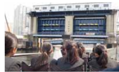
間近で見る天王洲水門
