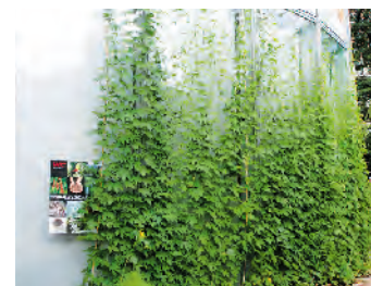
港区スポーツセンタープール棟
