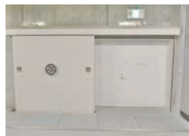
浸水対策エレベーターホール
