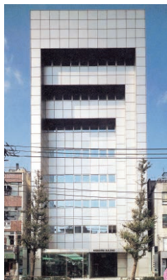
建築家・丹下健三設計の旧本社ビル
