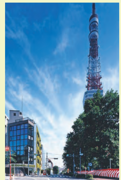
建物自体を一本の大木に見立てデザインされた長谷川グリーンビル(写真左手のビル)
