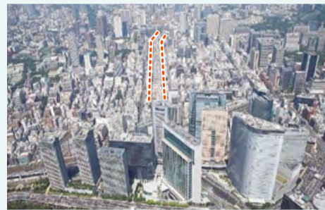
新橋方面から見た環状第2号線 (写真提供:森ビル株式会社)
