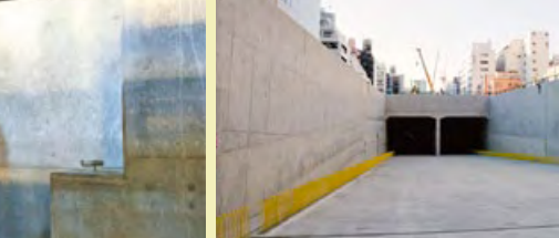
写真③ 消火設備用場所の工事
