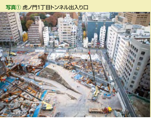
写真① 虎ノ門1丁目トンネル出入口
