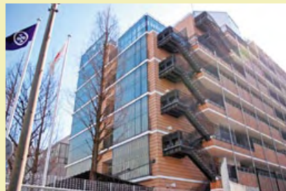
みなと保健所新庁舎
