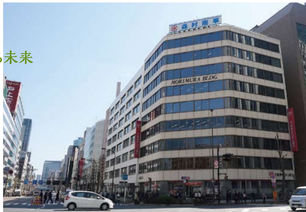
現在の「森村ビルディング」東京本社外観
