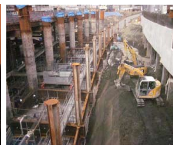
環2道路部分の逆打ち支柱と掘削
