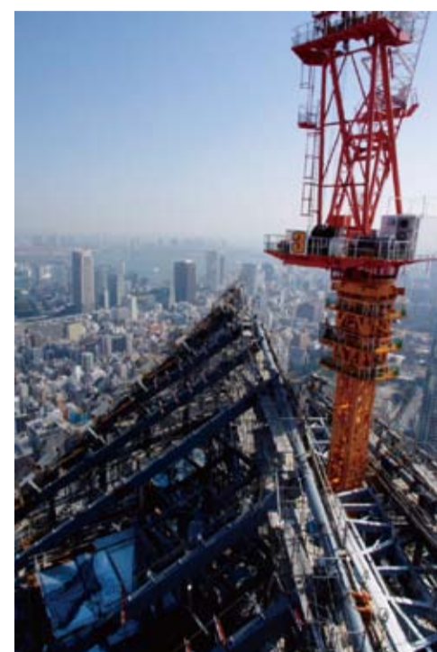
虎ノ門ヒルズ屋上斜屋根鉄骨とタワークレーン
