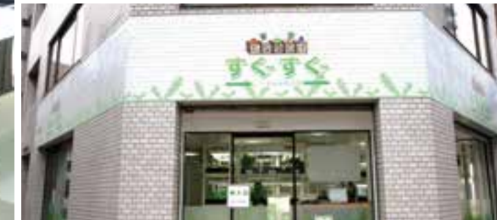
通りの角地でひとときわ日につく外観
