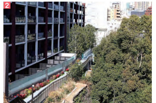
聖坂側から住宅棟-1の下を通る遊歩道
