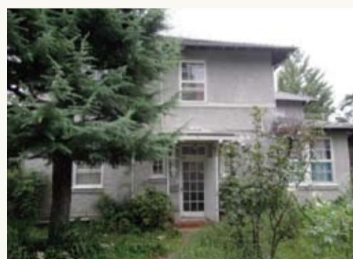
外観 煙突はとりはずされている
