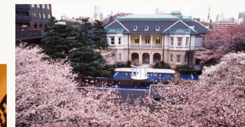
貴賓館(日本庭園側)
