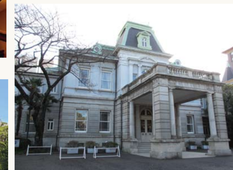
正面玄関(気品あるフランス式マンサード屋根とドーマ窓)
