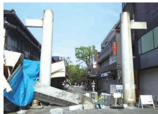
地震で壊れた水前寺公園入口の鳥居
